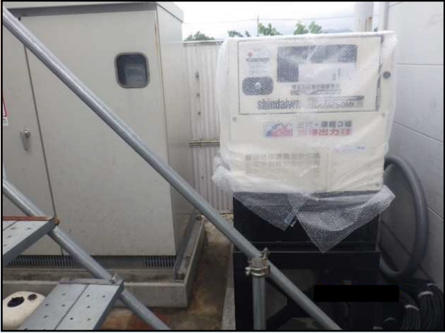
停電対策として発電機の設置
