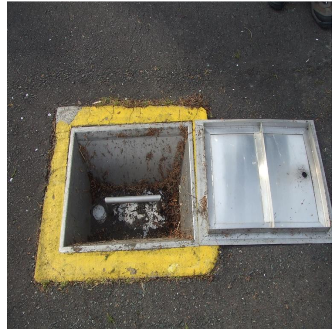
確保ロープの支点の状況
